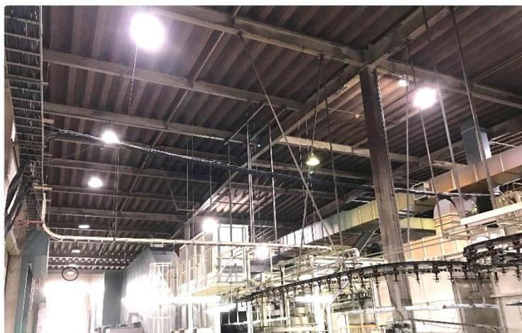
以前焼付炉の天井に導入した高温対応の高天井 LED 照明
